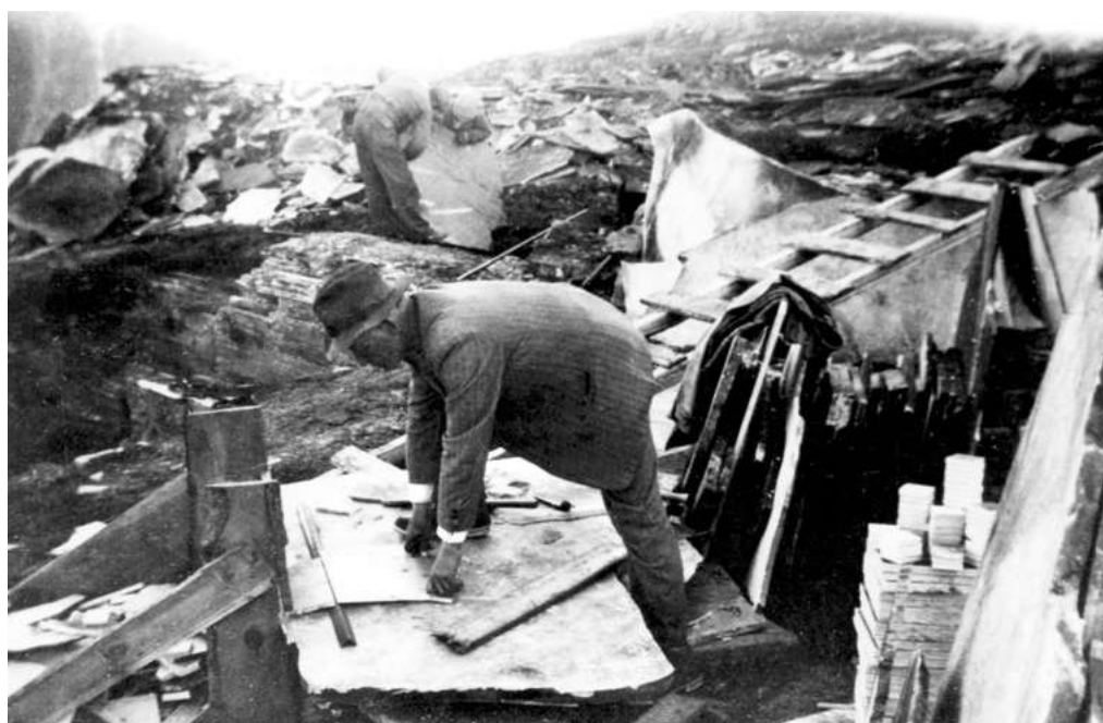
Olaf Skaslien driver prøveproduksjon av knekt skifer. Han prøver ut forskjellige knekkemetoder. Founder Olaf Skaslien is testing new ways to break schist.
