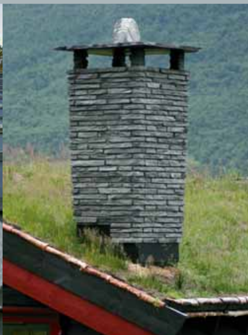
Pipe med skifermurstein.
