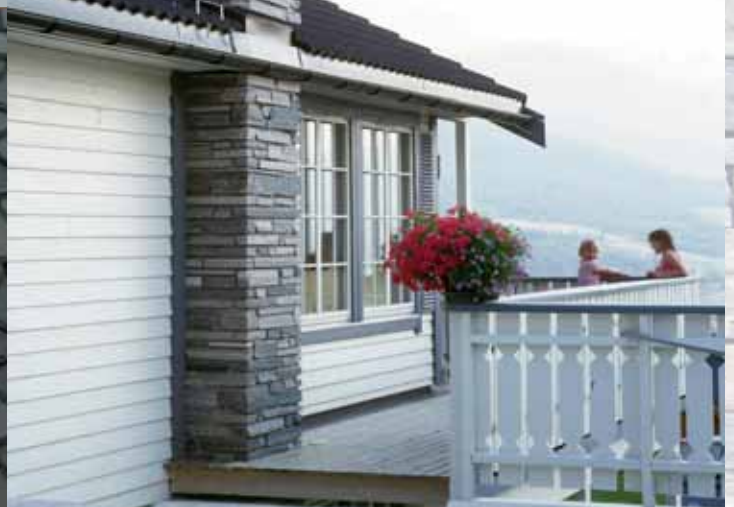
Pipe forblendet med en blanding av murstein og tørrmur.
