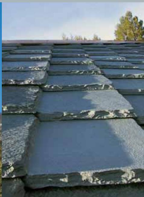
Takstein lagt i firkantmønster.
