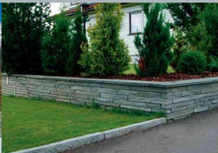
Mursteinsmur med avdekningheller oppe på muren.
