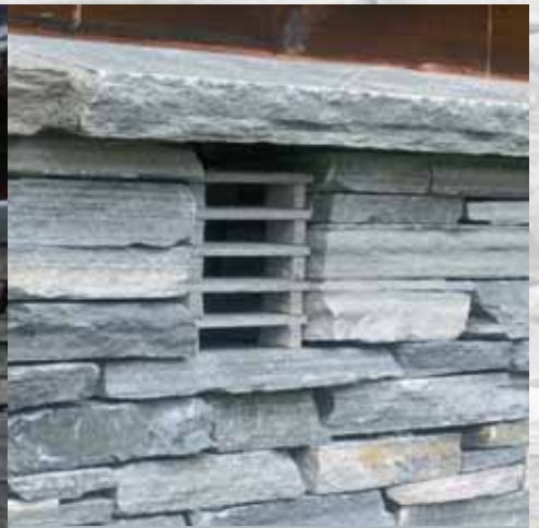
Utsnitt av tørrmur med ventil (også i skifer).
