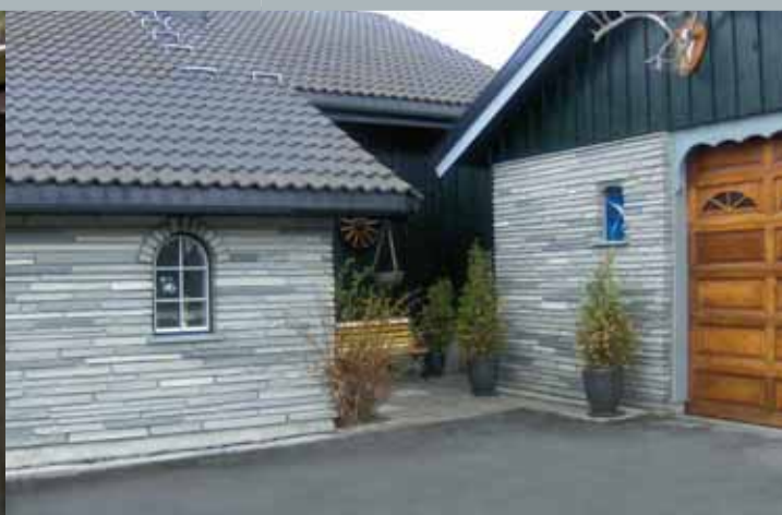
Mursteinsforblending på hus og garasje. NB! Se vindusløsningen.
