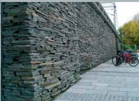
Høy mur stabilisert med betong i bakkant.
