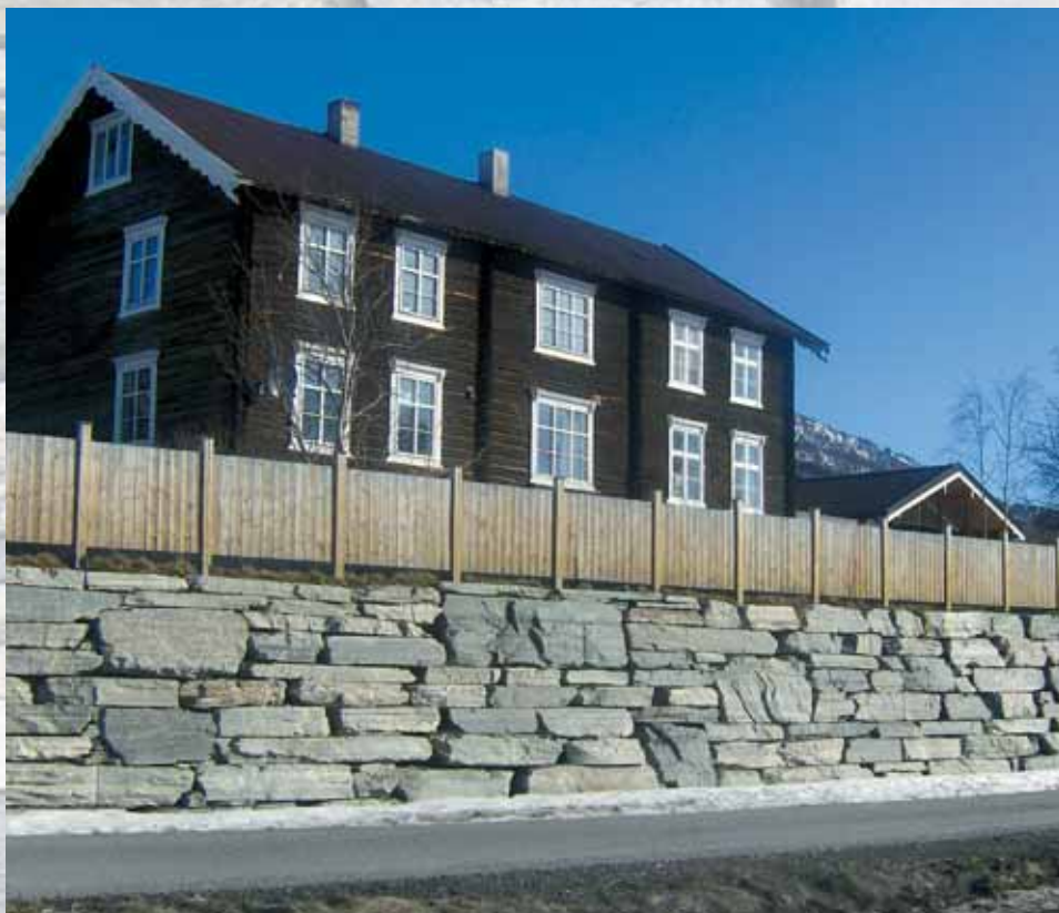
Forstøttningsmur av murblokk.
