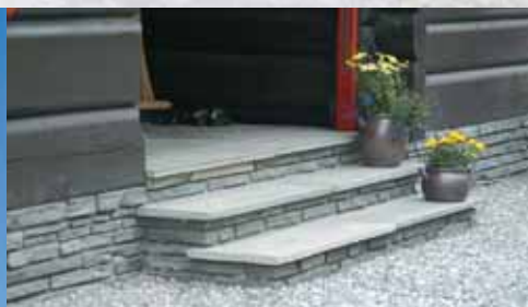
Murstein i opptrinn og på grunnmur.
