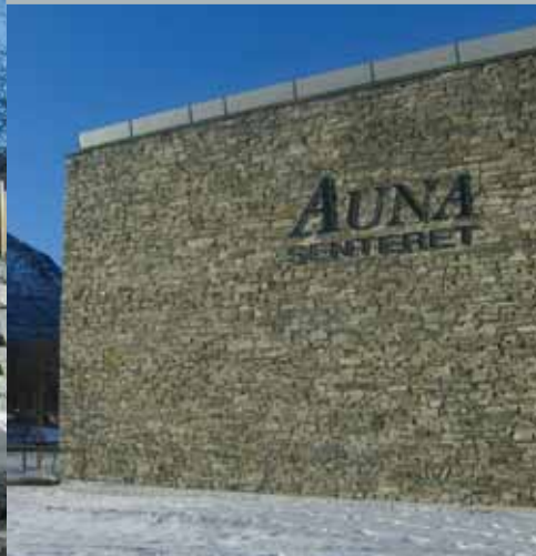
Fasade av tørrmur iblandet murkapp.
