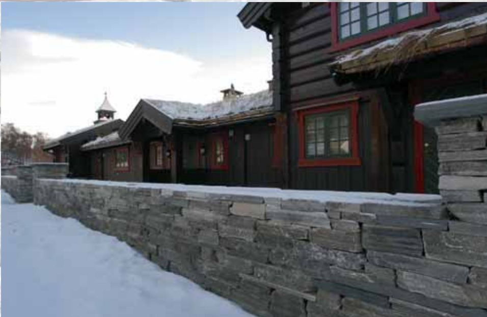
Tørrmur foran hytte. Skiferen er robust og tåler snø, kulde, sol og regn (Geir Dahle).
