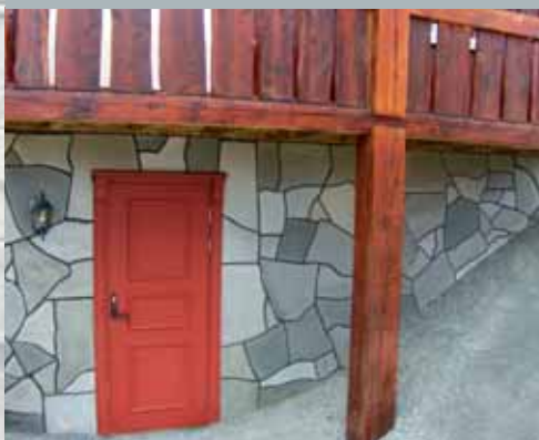
Sokkel forblendet med plastringsbrudd.
