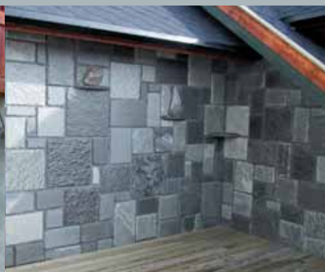
Plastring med firkantstein i ulike størrelser.
