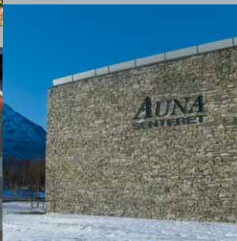
Tørrmur- og murkappfasade
