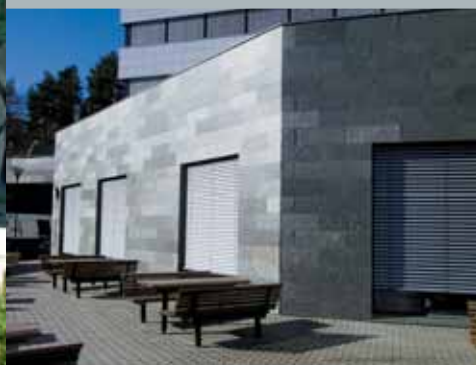
Fasade kledd med rektangulære fliser.
