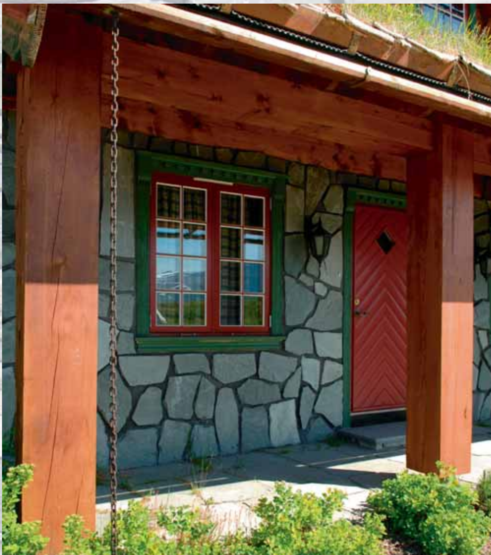
Grovplastring på veggen, og svalgang av bruddheller.
