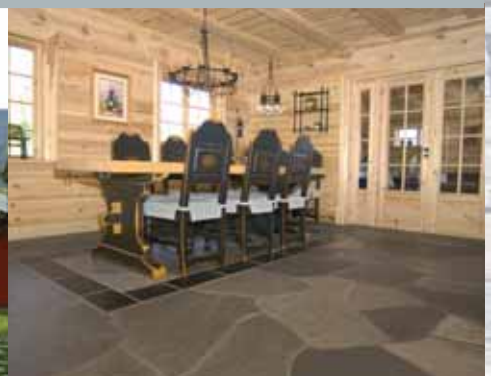
Bruddhellegulv. Gulvflis rundt bordfot (Geir Dahle).
