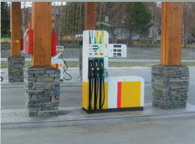
Bensinstasjon med ulik bruk av tørrmur.
