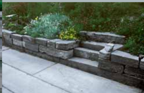
Blomsterbed med stor tørrmur, trapp med terrengtrinn.
