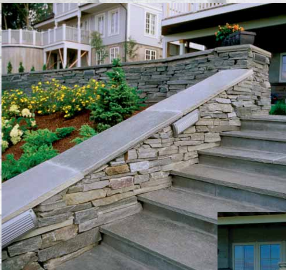
Trapp og tørrmur. Avdekningsheller på toppen av muren.
