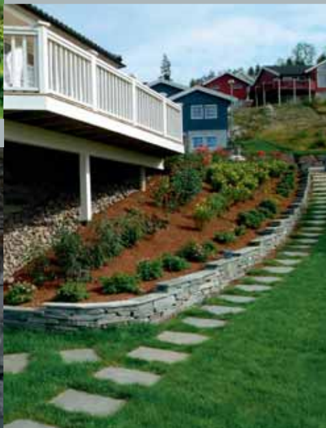
Tråkkheller i forgrunnen. Tørrmur med avdekningsheller.
