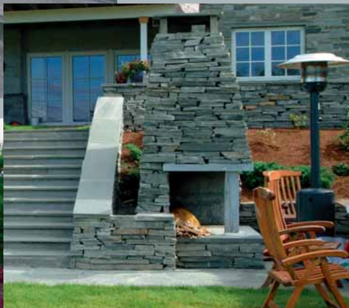
Trapp og tørrmur med avdekning på toppen. Peis i tørrmur.
