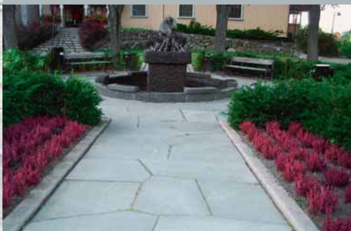
Store bruddheller i parkanlegg.
