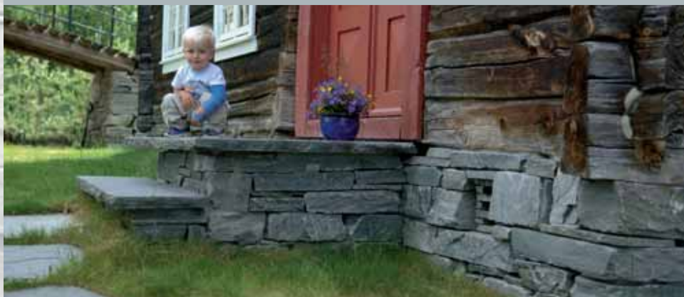
Trapp og grunnmur i tørrmur. Grovt tilhugne trappheller.
